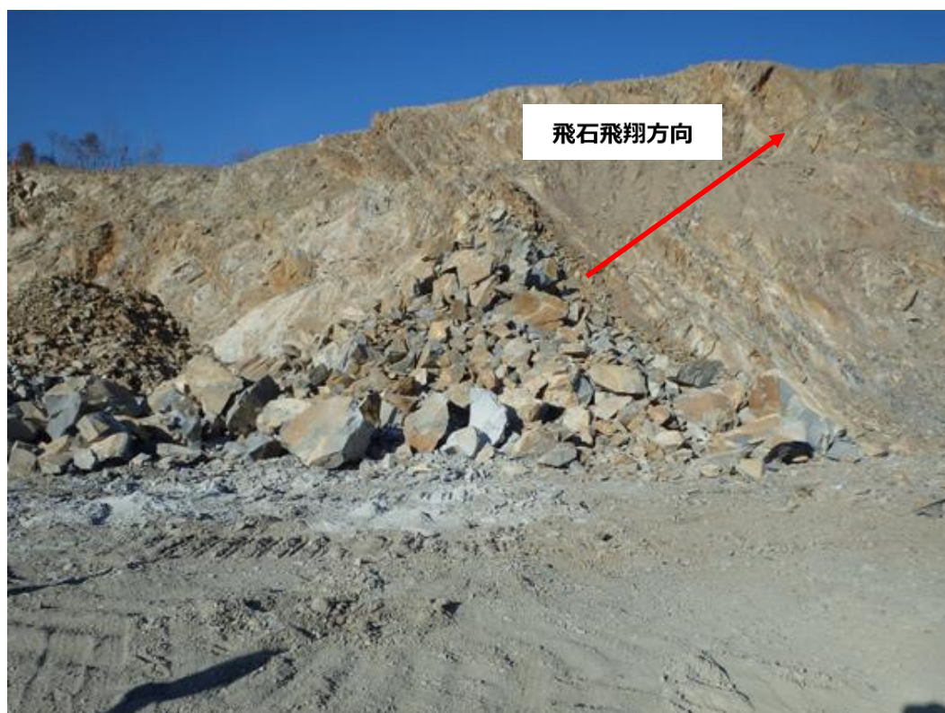
写真2 発破箇所（正面）
