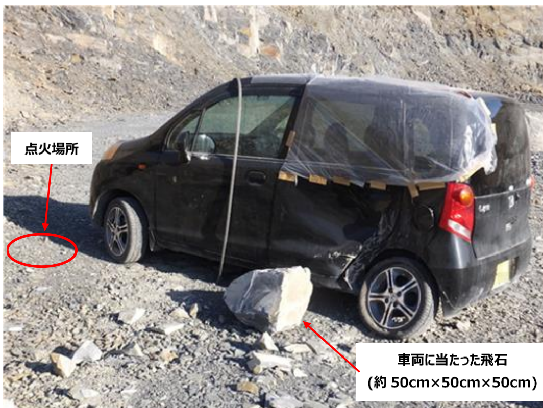
写真4 点火場所と飛石が当たった車両
